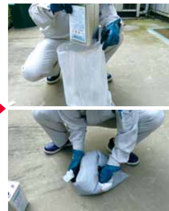
樹脂と骨材の混練
